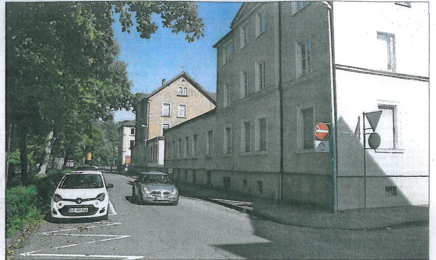
Josefstraße: Der rote Giebel der Mitte gehört zum einstigen DRK-Areal und bleibt erhalten. Das Wohnhaus im Vordergrund mit dem flachen Fabrikbau dient über Jahrzehnte als Domizil einer Anwaltskanzlei. Das Gebäude wird abgerissen, um Platz für elf Eigentumswohnungen zu bieten. Fotos: gbr
