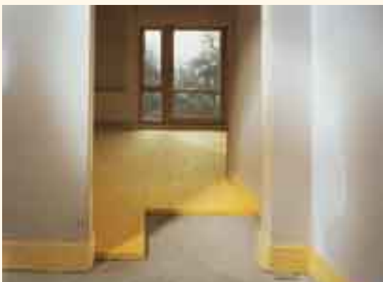
Dämmung des Erdgeschoss-Fußbodens
