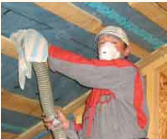
Das Einblasen der Zellosedämmung ins Schrägdach
