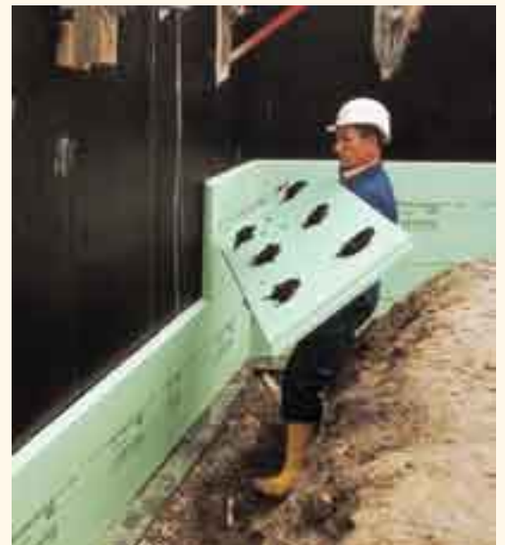
Anbringen der Außendämmung im Kellerbereich
