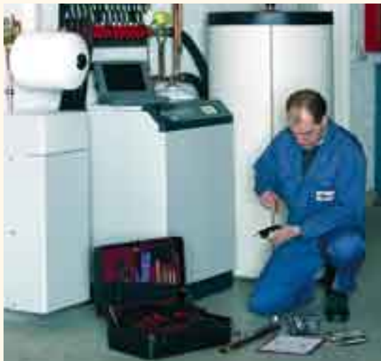
Montage einer Erdwärmepumpe
