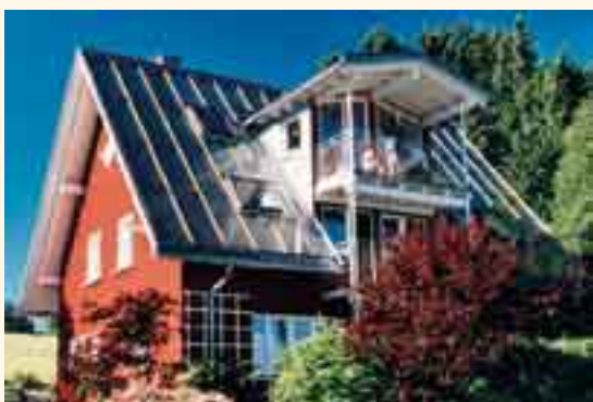
Die gesamte Süd-Dachfläche dieses Hauses ist ein Solarkollektor. Er deckt den größten Teil des Energiebedarfs ab.
